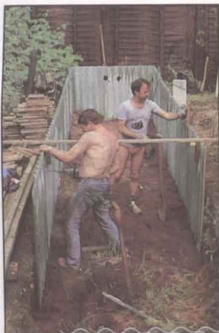
18. Bez šňůry a vodováhy to při stavbě stěn nejde. Stačí ale jeden provrtaný otvor, aby se dvě desky spolu spojily, a za jeden den je vnější kostra vysokého záhonu hotová.
